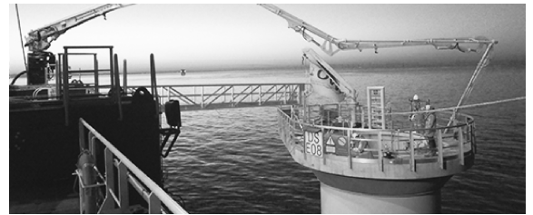
图10 单桩基础灌浆施工图
