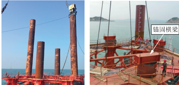
(a) 临时桩插打 (b) 安装锚固导梁
