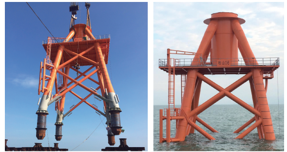
(a) 导管架安装前
