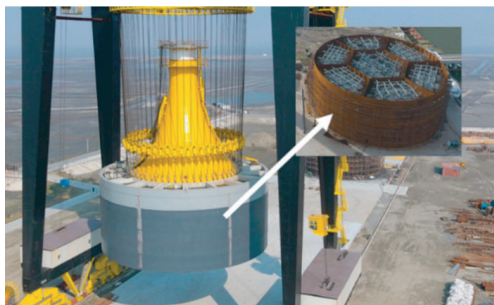
图1 复合筒型基础
