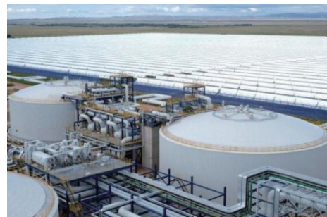
图 1 双罐储热系统
