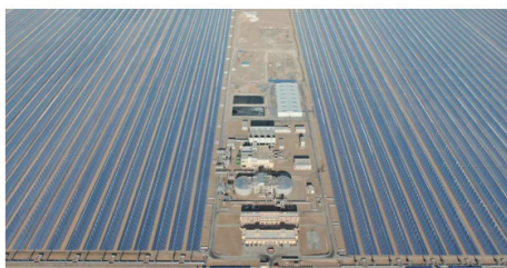
图 7 甘肃玉门 100 MW 光热电站 Fig. 7 100 MW CSP power station in Yumen, Gansu Province
