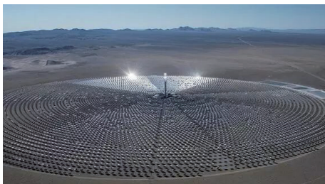
图 5 美国新月沙丘光热电站 Fig. 5 Crescent Dunes CSP project
