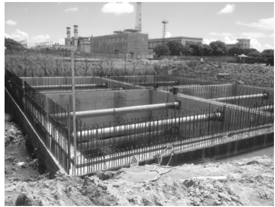
图 8 沉井终沉阶段
