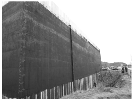
图 7 沉井初沉阶段
