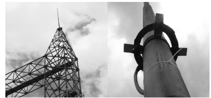
(a) 国家(昆明)特高压工程实验室
