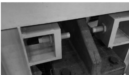
图5 锁定装置应用图-Y方向
