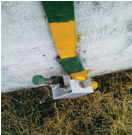
图 7 接地桩上面安装的钥匙闭锁锁具
