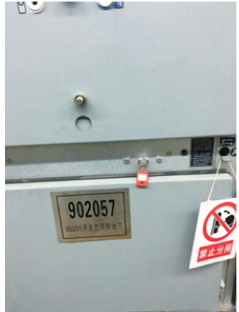
图5 中压盘柜地刀上安装的闭锁锁具
