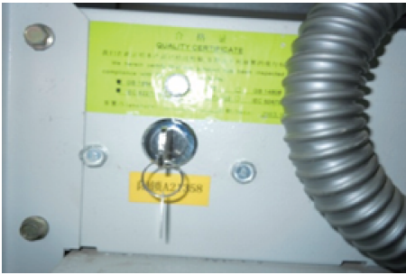
图2 中置小车式开关 KYN28 安装的闭锁锁具
