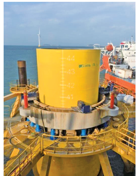
钢管桩嵌岩现场施工图
