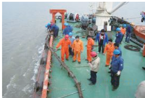
图4 海底光缆线路施工检修作业
