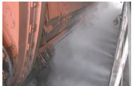
图4 翻车机室干雾作业现场
