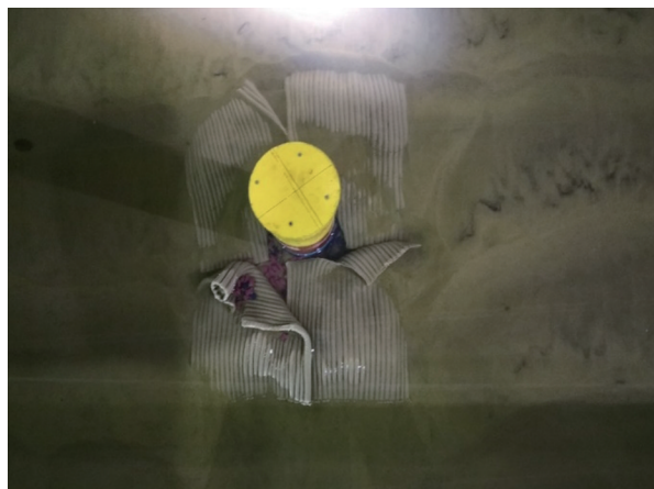
(a) 砂被沿逆流方向搭接
