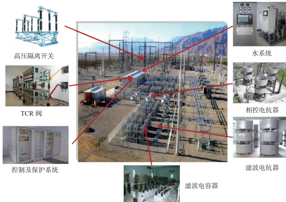
图 8 无功补偿及谐波抑制系统配置
